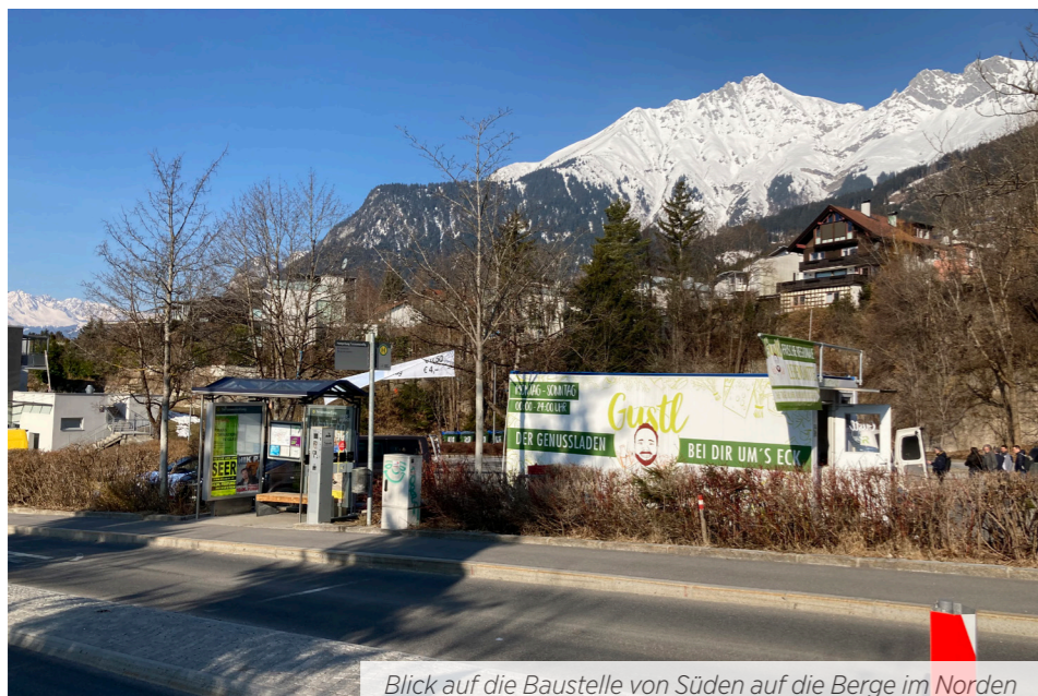
Blick auf die Baustelle von Süden auf die Berge im Norden
